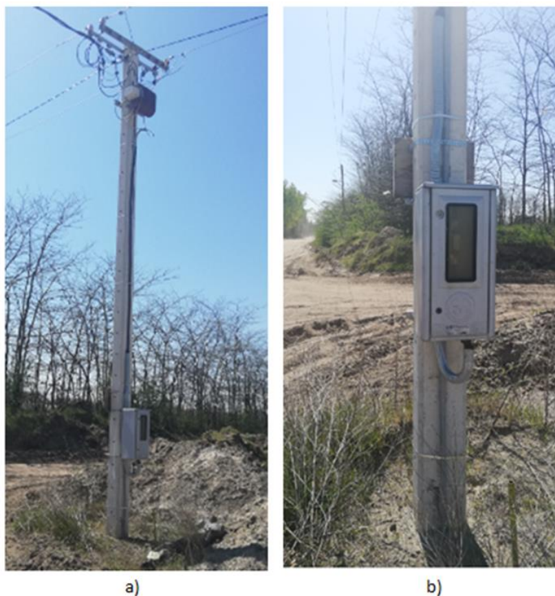
SLIKA 3 – TEHNIČKO REŠENJE U OGRANKU ED SUBOTICA ZA POBOLJŠANJE NAPONSKIH PRILIKA U NN MREŽI U ULICI JOVANA MIKIĆA, A) STUB UN-9/30 SA VROT-18 I B) POMM-1 SA AUTOMATSKIM OSIGURAČEM
